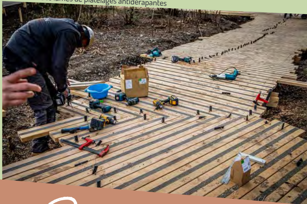
▲► Finition du platelage avec découpes de lames
