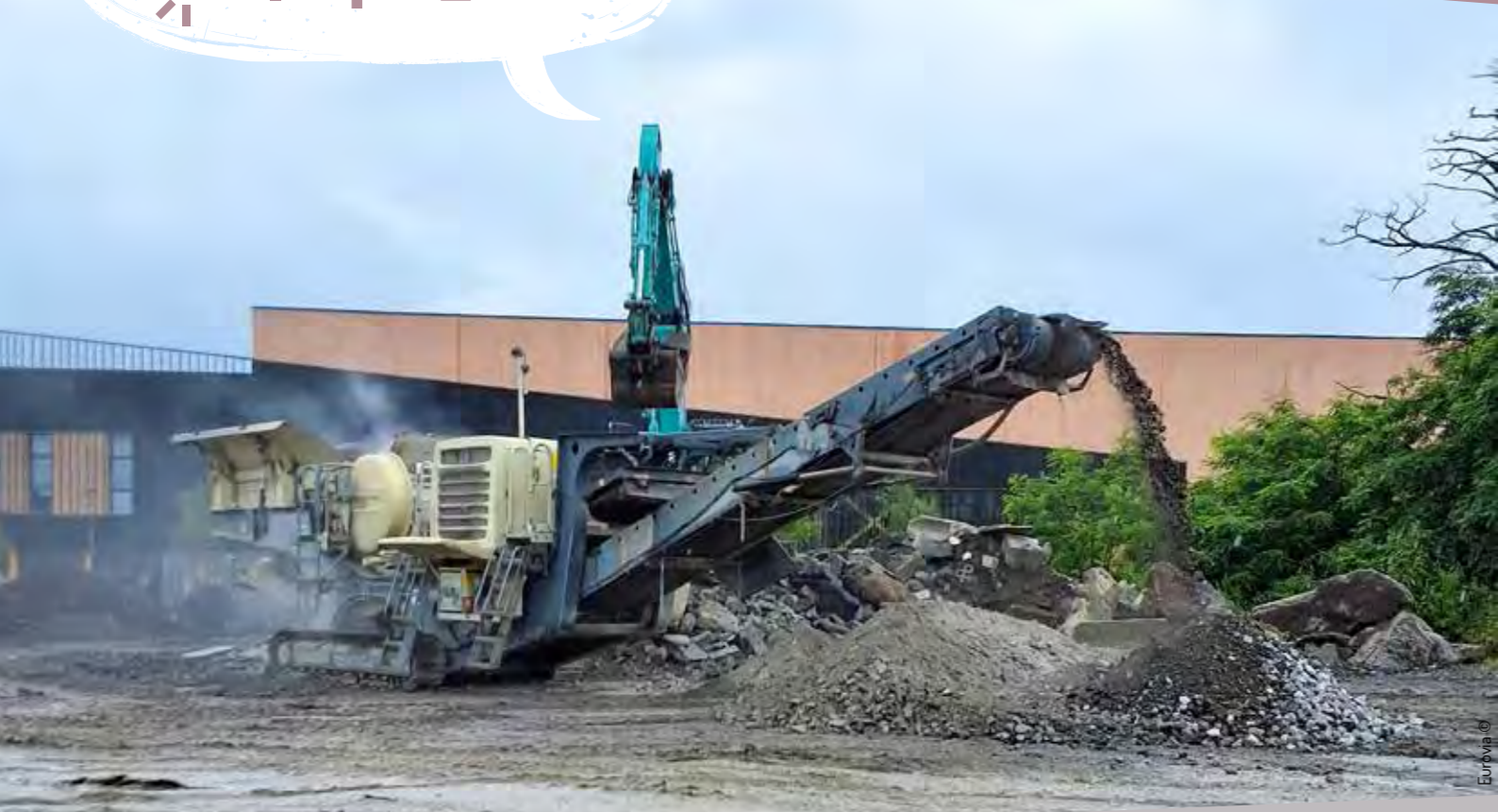
▲ Evacuation des matériaux concassés de la centrale de concassage
