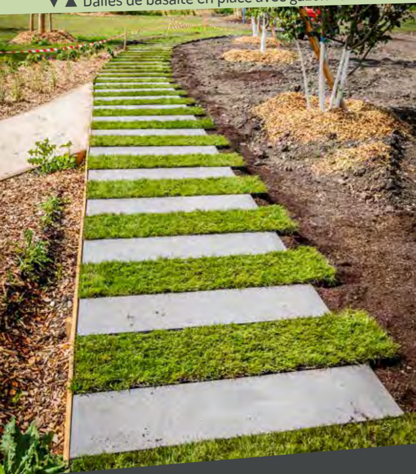
▼ ▲ Dalles de basalte en place avec gazon renforcé
