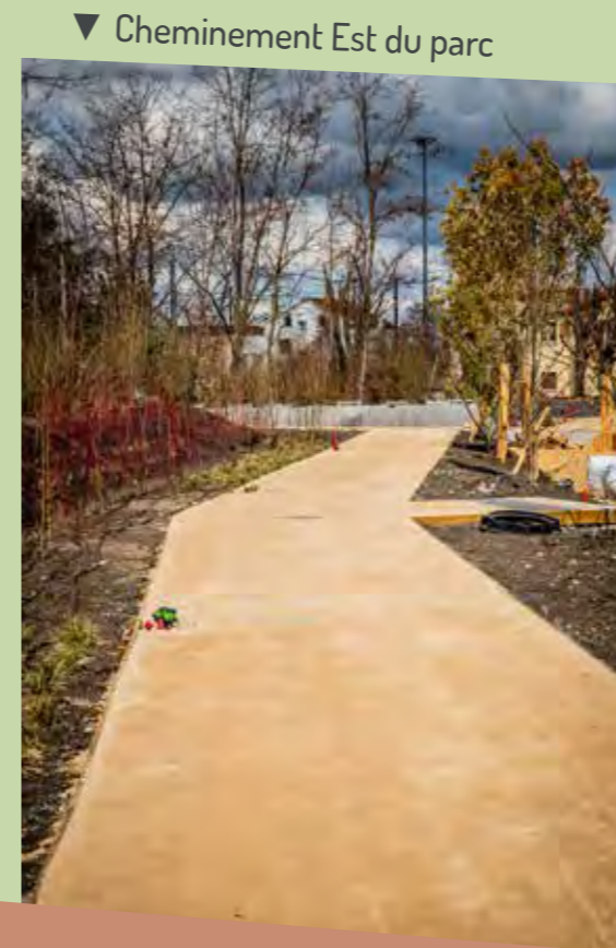
▲ L'allée des platanes après mise en place des sables stabilisés
