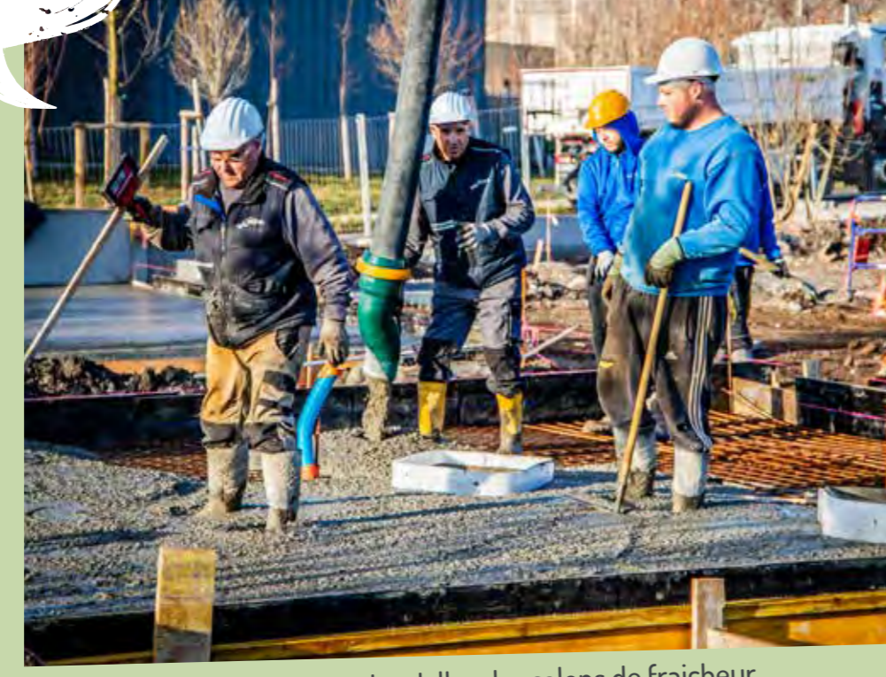
▲ Coulage des bétons des dalles des salons de fraicheur
