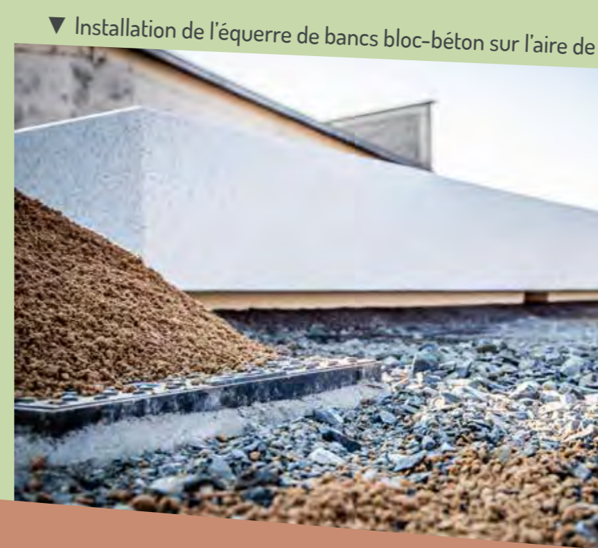
▲ Installation des bancs bloc-béton sur les trottoirs : chaque banc pèse 1,2 tonnes
