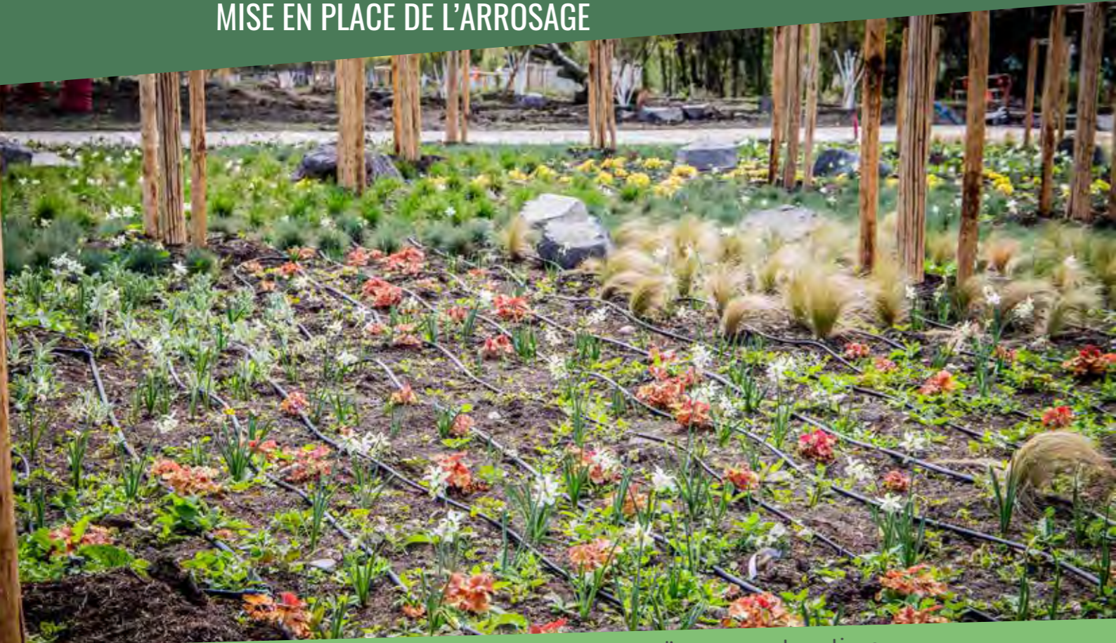
▲ Plantation des massifs des ginkgo et mise en place du réseau d'arrosage automatique
