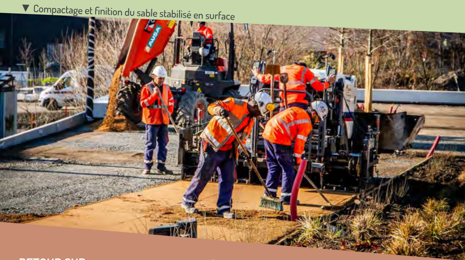
▲ Déversement du mélange de sable et de chaux sur la couche d'assise en grave non traitée
