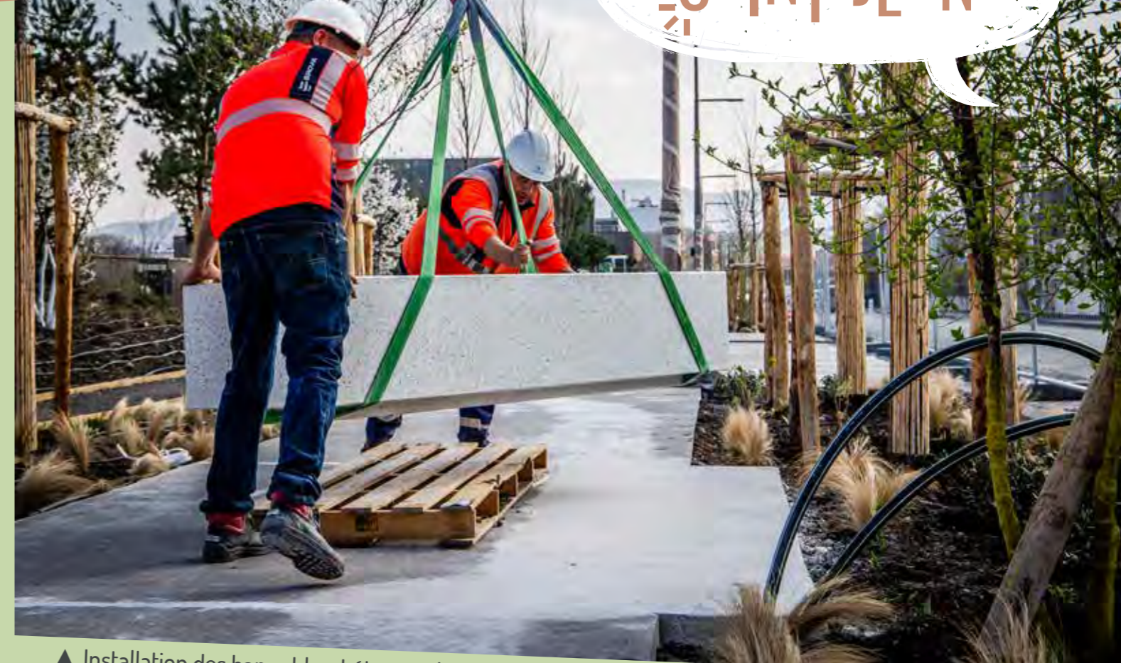
▲ Installation des bancs bloc-béton sur les trottoirs : chaque banc pèse 1,2 tonnes
