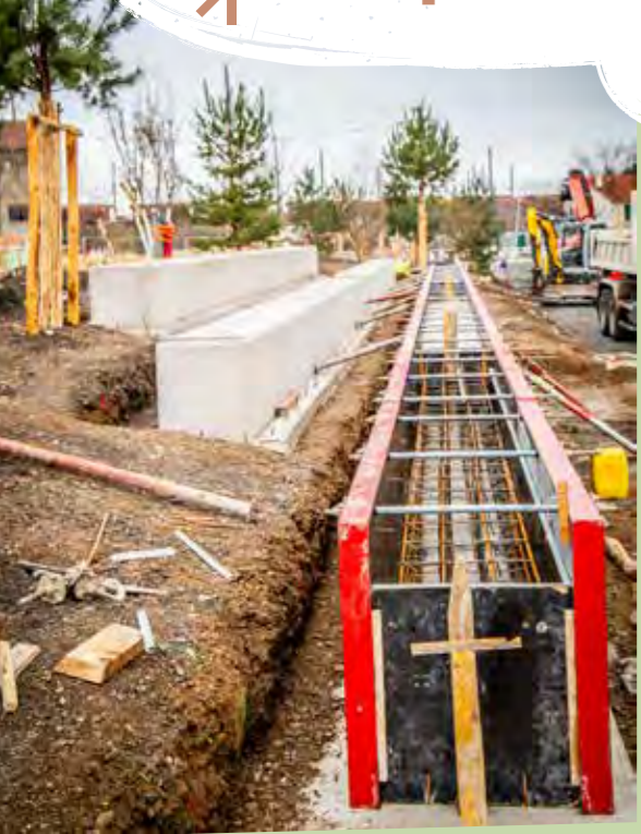
▲ Mise en oeuvre des gradins
