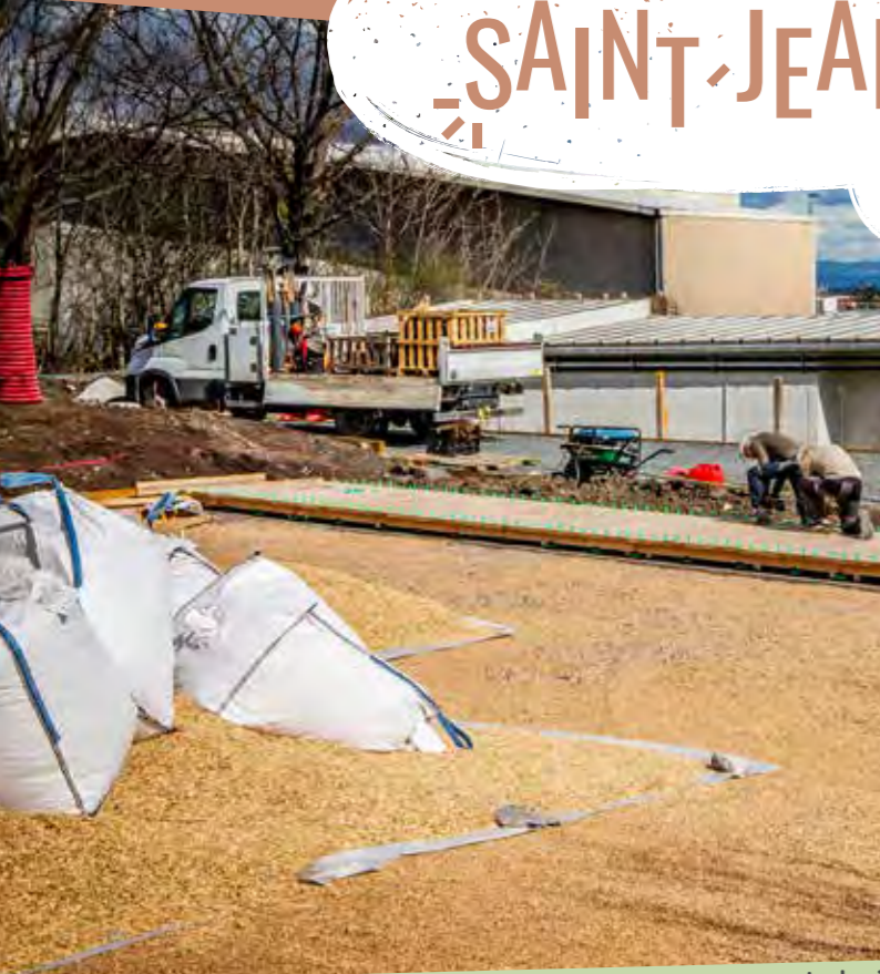
▲ Mise en place du sol amortisseur en copeau de bois
