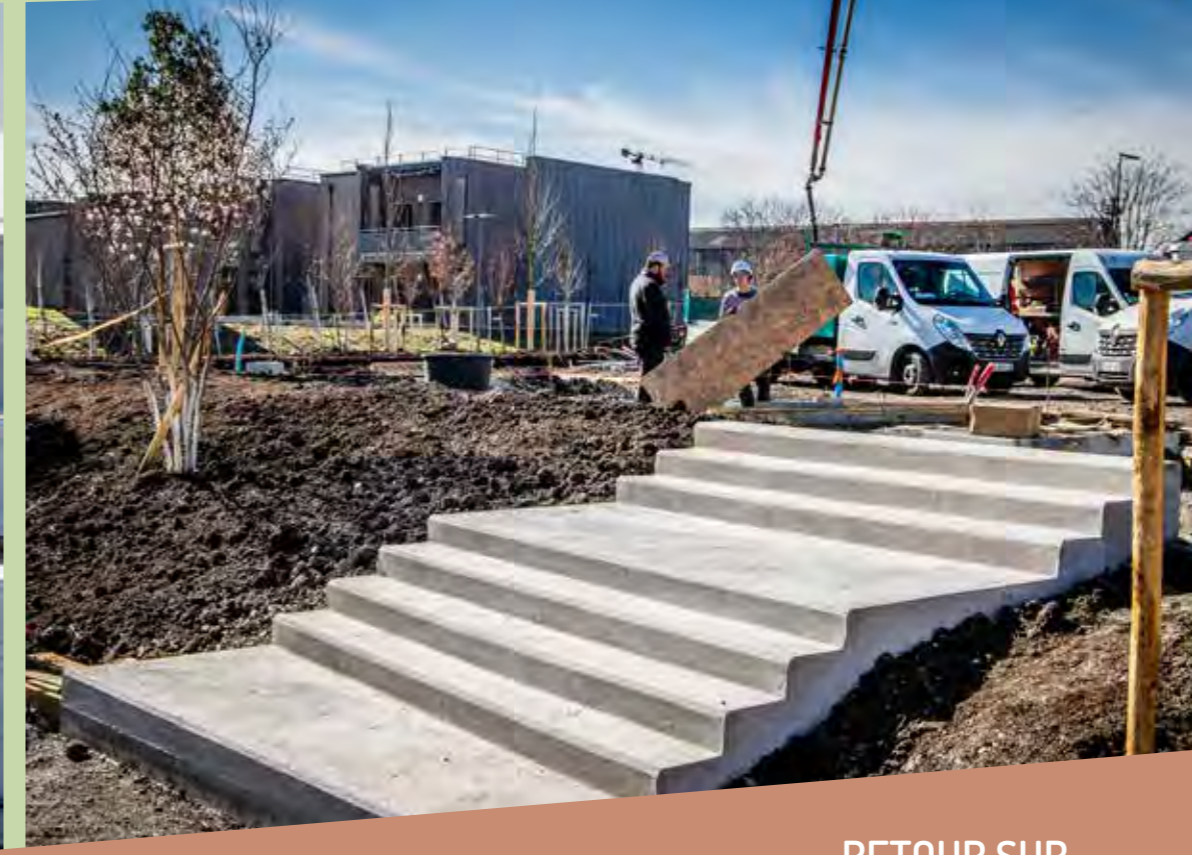
▼► Décoffrage des bétons des escaliers et finition à la taloche
