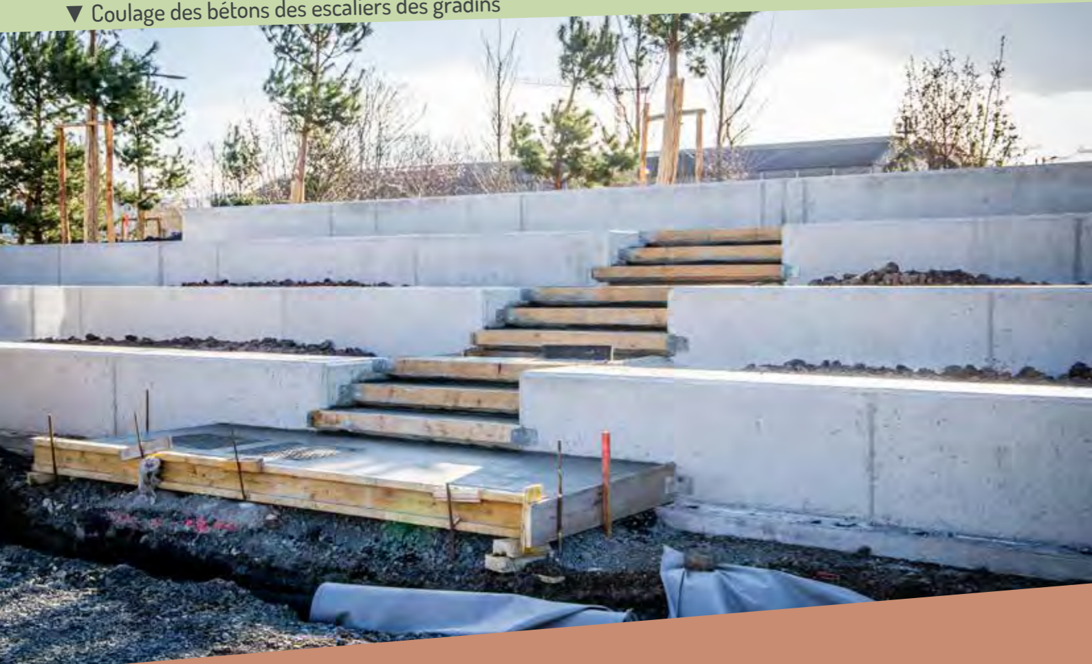
▲ Mise en oeuvre des gradins
