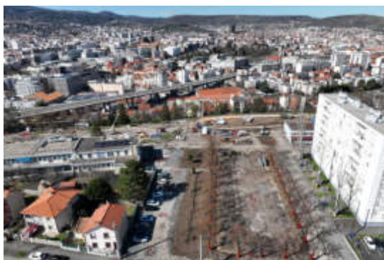
Vues aériennes du chantier du parc de Saint-Jacques (2025, Photovideodrone)
