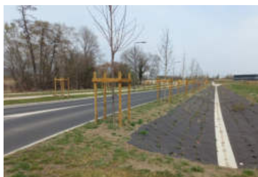
Voie Sud réalisée (2023)
