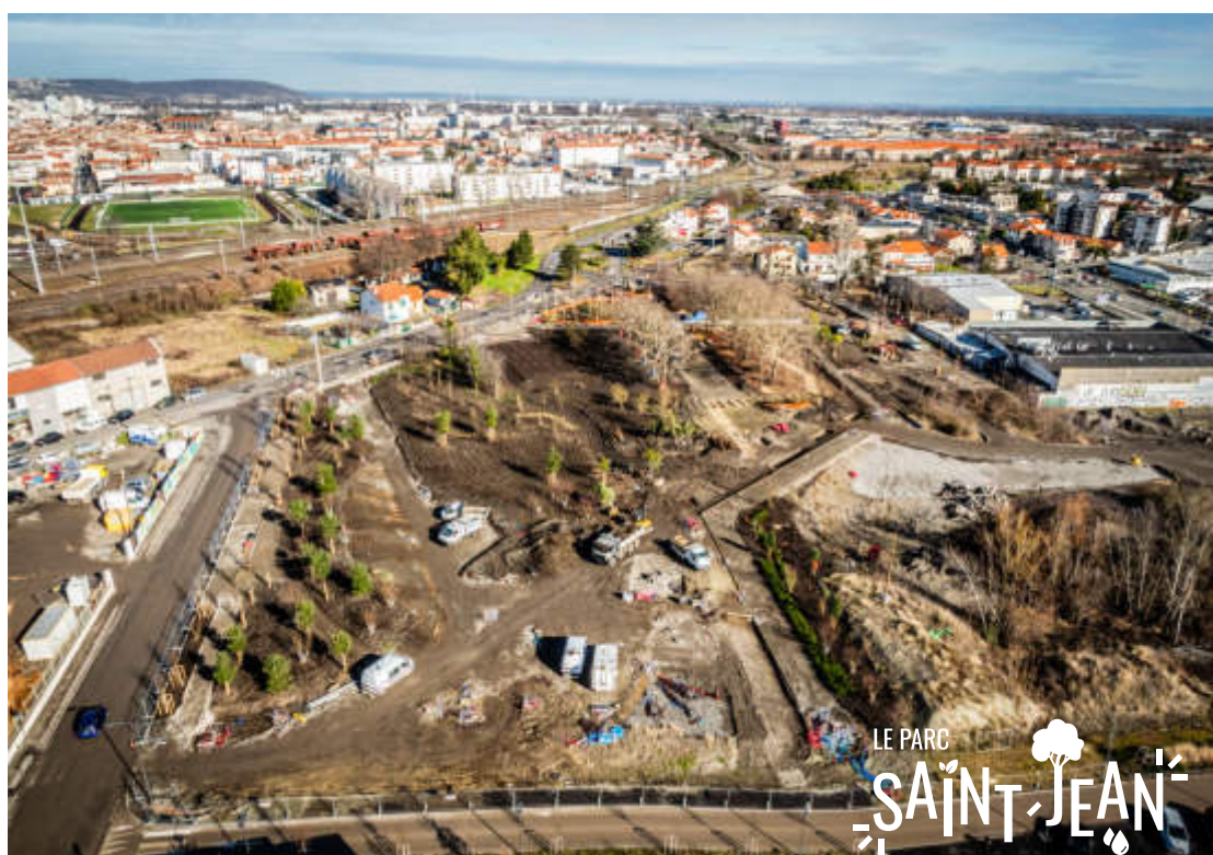
Vue aérienne du chantier du parc de Saint-Jean (2025, Photovideodrone)
