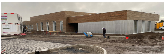
Vue depuis l'entrée du site (2026)
